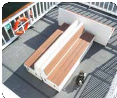
Bild 7. När du monterat däckets bör du rengöra det från sågdam m.m. med ett rengöringsmedel som innehåller oxalsyra. Därefter räcker det med normal rengöring som med alla utomhuskonstruktioner.
