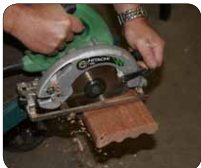
Bild 6. När du lagt däckets ska kapa ändarna ställer du in cirkelsågen på rätt sågdjup. Gör en markering med slagsnöret och såga. Jämn av sågytan med rasp.
